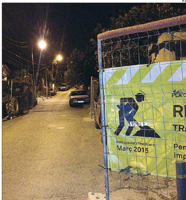
Les obres al carrer Morató s'han aturat des de fa tres setmanes
