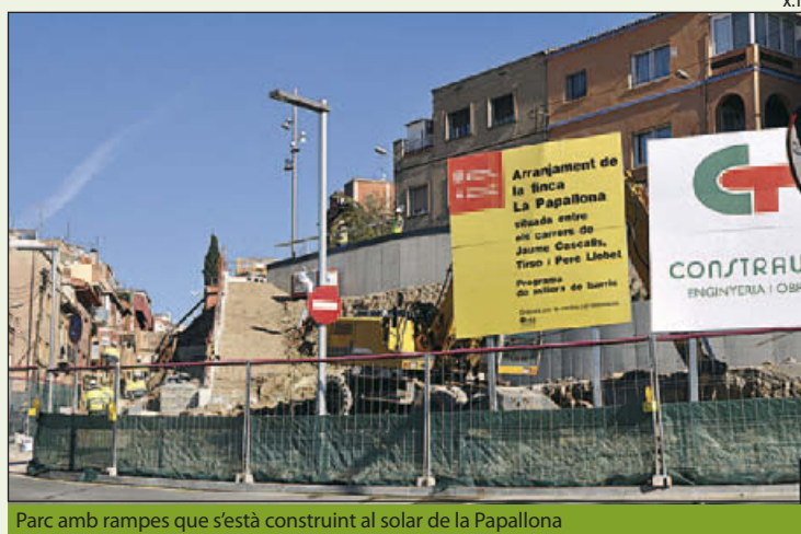
Parc amb rampes que s'està construint al solar de la Papallona
